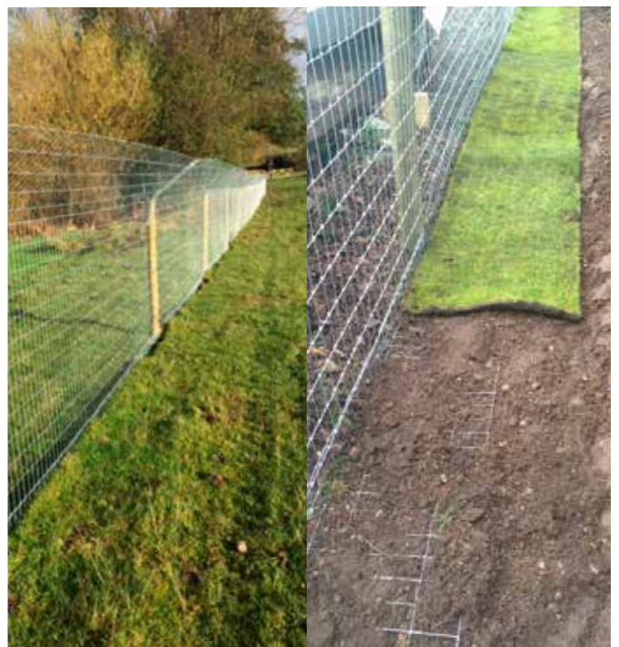
Abb. 5.28: Festzaun mit Überhang und umgelegtem Untergrabschutz (entnommen aus https://www.otterstop.co.uk/media/gallery/ )
